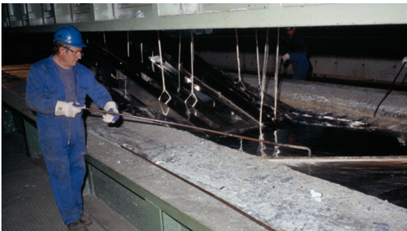
Intervention dans un bain de galvanisation
